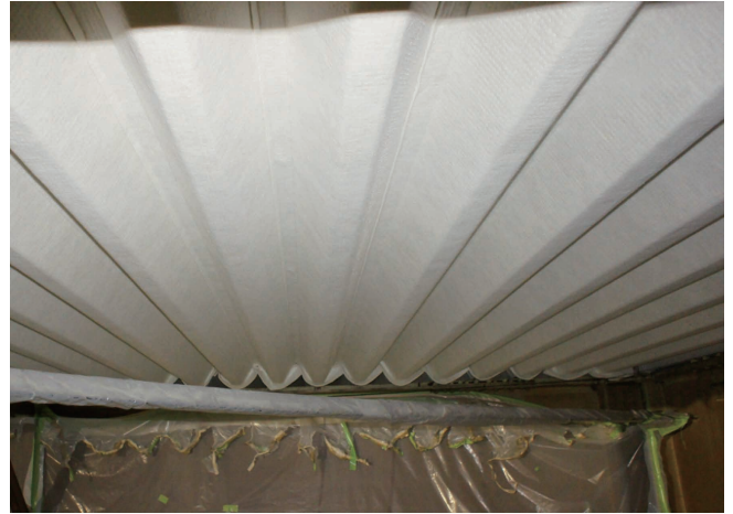
断熱材貼り付け後 (ガラス繊維シート断熱材)
