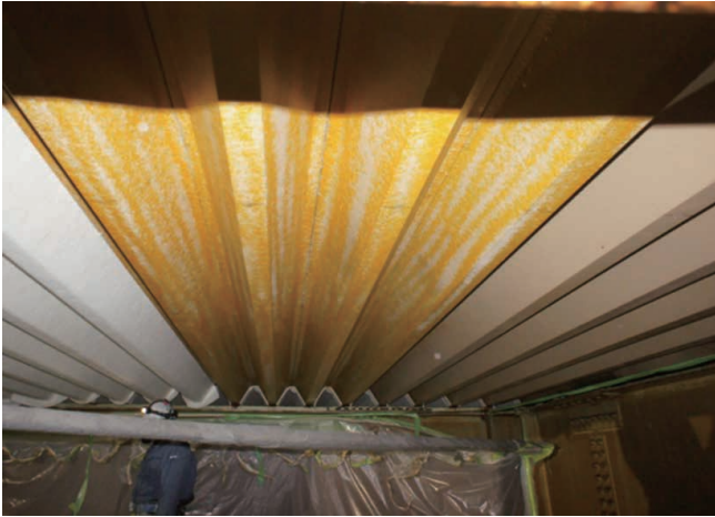
断熱材貼り付け前 (ガラス繊維シート断熱材)
