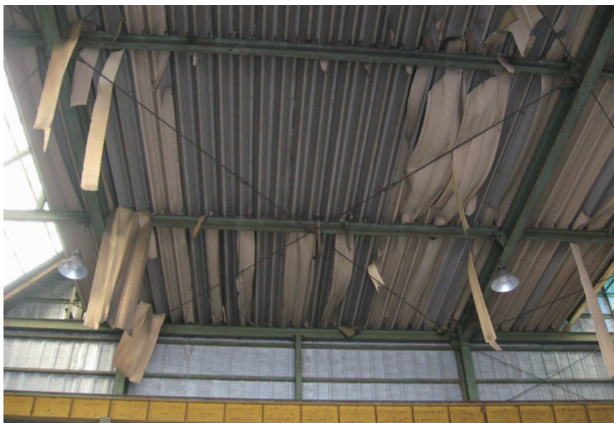
紫外線による劣化と接着不良
