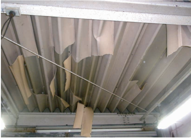
断熱材復旧前 (無機質高充填フォームプラスチック)
