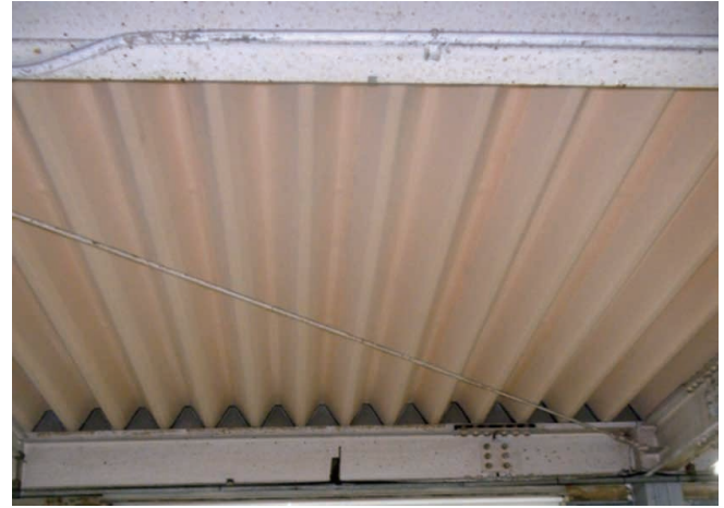
断熱材復旧後 (無機質高充填フォームプラスチック)
