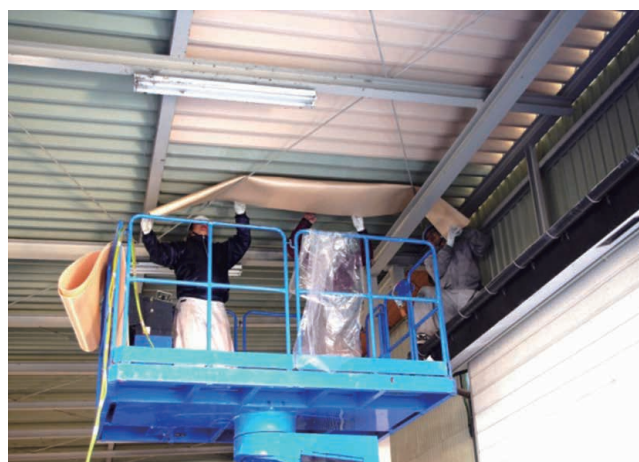
折板屋根への断熱材貼り付け
